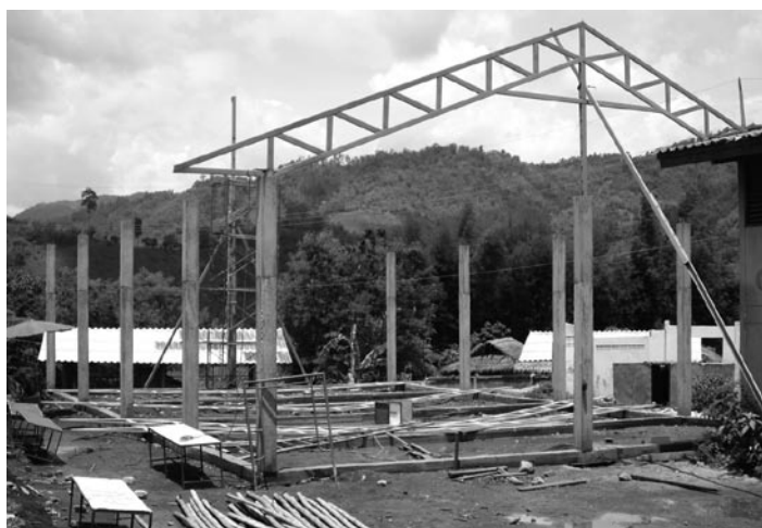
(食堂兼講堂建築の様子)
